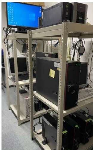
サーバーの管理
